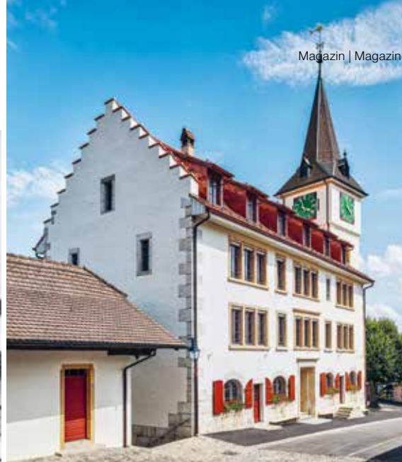
Schulhaus, Märit 4, Erlach, nach der Sanierung 2020 Foto: Damian Poffet, Bern-Liebefeld für Thomas De Geeter Architektur GmbH, Zürich
