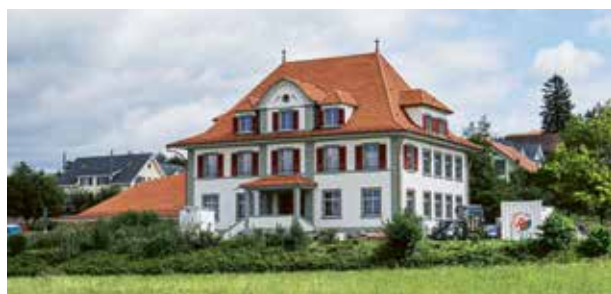
Schulhaus Seedorf nach der Sanierung
