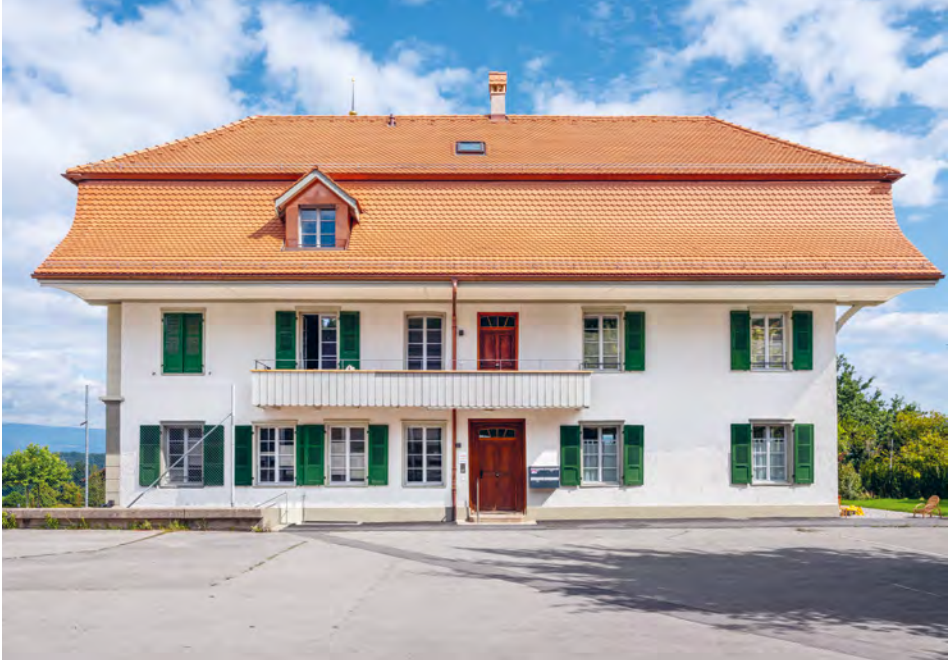
Dacheindeckung mit Biberschwanzziegeln Fotos: Pawlik + Wiedmer GmbH
