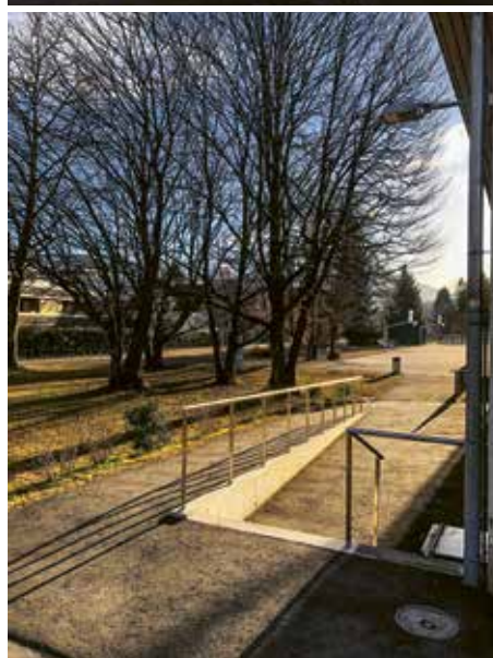
Rampe hinter der Turnhalle Foto: langhard architekten ag Gwatt, 2020
