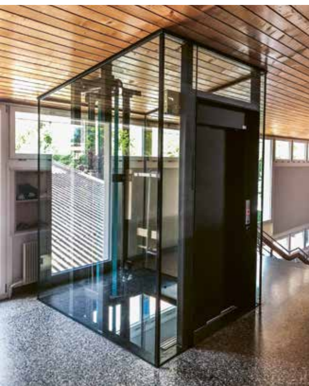
Personenlift im Inneren des Schulhauses Foto: langhard architekten ag Gwatt, 2020
