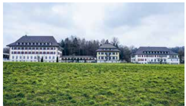
Schulhäuser, Lehrer- und Verwaltungsgebäude Waldhof, 2018
