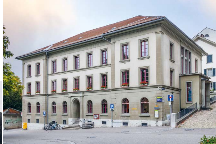
Das Gebäude um 1905 und heute
